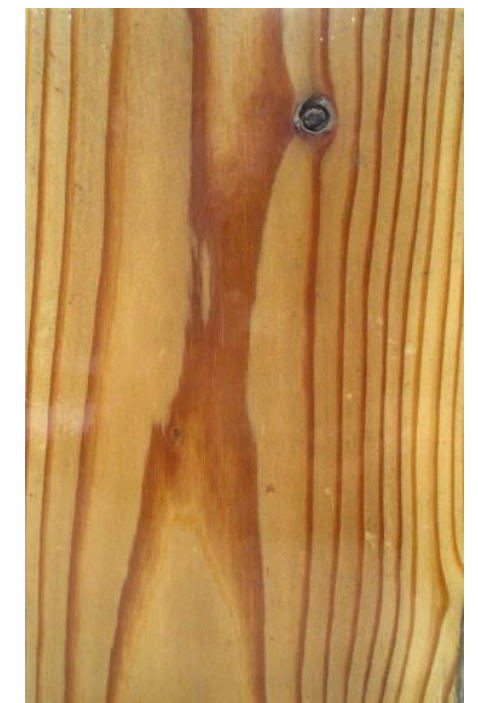
カラマツ材 屋外曝露 3 年間 塗膜の割れ・膨れ・剥がれ・ 白化等の劣化は見られない。
